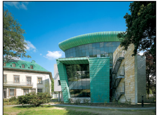
Photo : crédit KM Europa Métal AG, Allemagne
