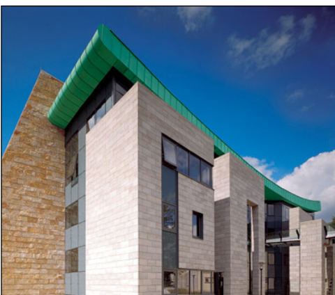
Photo : crédit KM Europa Métal AG, Allemagne
